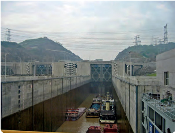
Bild 1d: Blick in die unterste Schleusenkammer.
