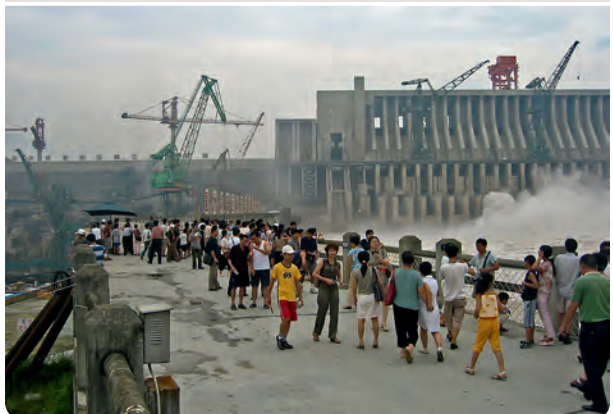
Bild 1a: Die Drei-Schluchten-Projekt-Staumauer als Attraktion für Touristen. Nach dem Aufstau auf 135 m hat die Stromproduktion begonnen. In der linken Bildhälfte wird noch der oberste Abschnitt der Staumauer errichtet, in der rechten ist die auf 185 m ü. M. gelegene Mauerkrone zu erkennen.
